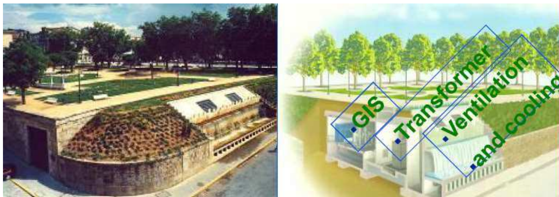
4.2 ábra – Spanyol földalatti 145 kV-os állomás 16
