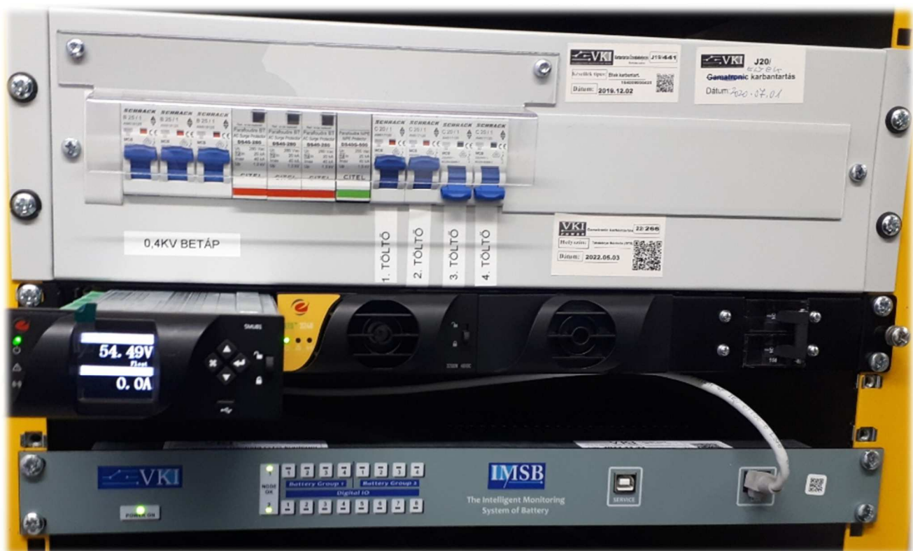
34. ábra ELTEK 0.4kV-os PDU felül, enetek converter közepén, IMSB alul 37
