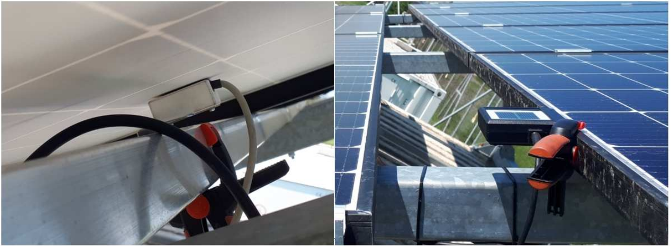
66. ábra Hőmérséklet és besugárzás (megvilágítás) mérők elhelyezése 69
