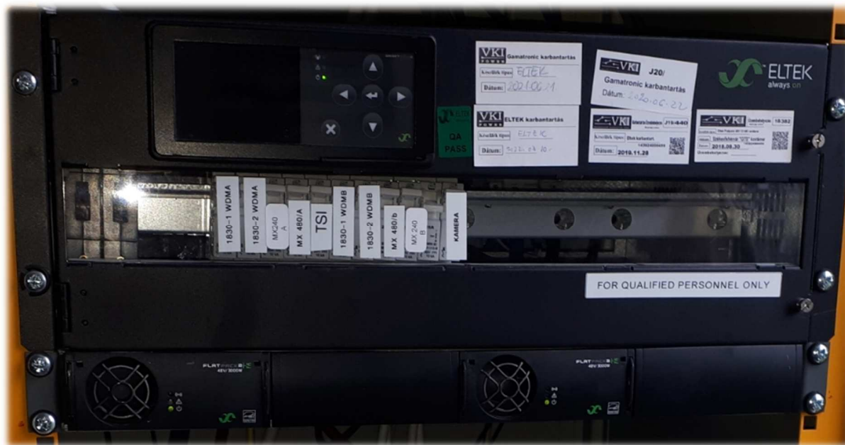
4. ábra „A” állomás energiaellátója a fogyasztói leágazásokkal 4
