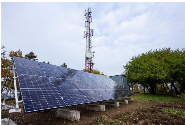
9. ábra. Talajra telepített napelem táblák, és tartószerkezetük, elkészült kivitelezése. 13
