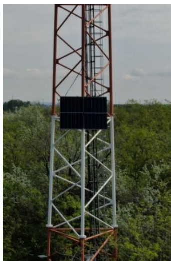
30. ábra. Övrúdra szerelt könnyített és forgatható tartószerkezet prototípusának szerelési próbája. 24
