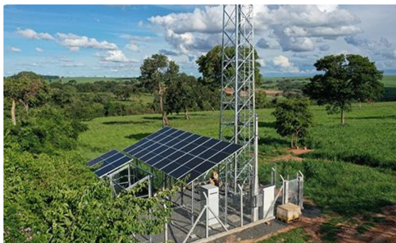
10. ábra. Növényzet, kerítés fölé emelt, talajszintű telepítés. 14
