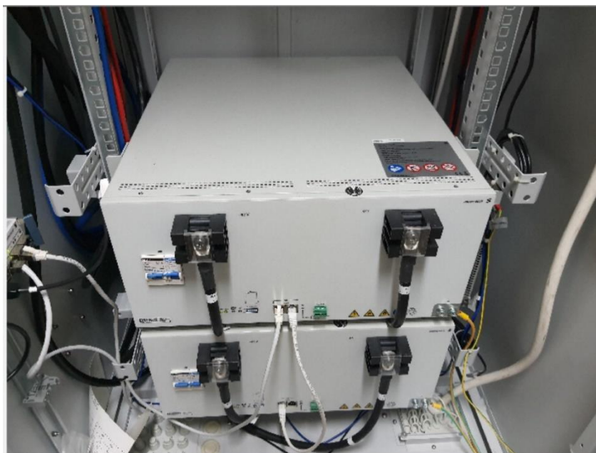
2x200 Ah-ás LiFePO4 akkumulátor, energiatárolásra. 27
