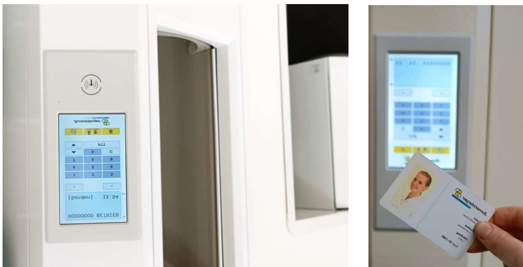
6.9 ábra: Az állomásvezérlő érintőképernyő ezüst-ion felületkezeléssel és érintésmentes kapszula fogadással
