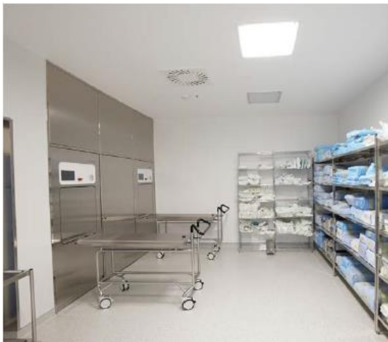
10. ábra Sterilező elhelyezése falba építve [27]
