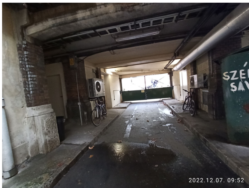
23. ábra: fotó - gazdasági bejárat, az utólag létesült átkötő épületszárny alatt (mentőforgalom ebből az irányból történik a lift megközelíthetősége miatt) [forrás: saját fotó]
