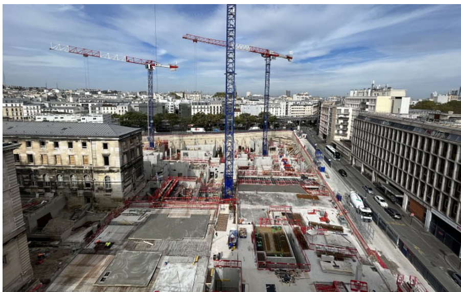
42. ábra: fotó - „Nouveau Lariboisière” építkezése toronydaruból fotózva (2023. december) 22 [16]
