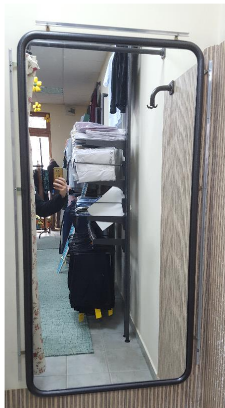
4.19. ábra. A tükör keretére felszerelt alumínium profilok [saját kép]
