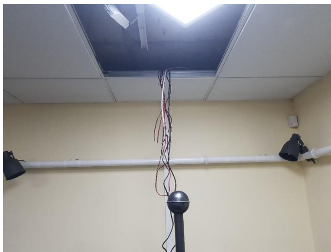
4.23. ábra. A fűtéscsövön rögzített keskenyen sugárzó lámpatestek [saját kép]
