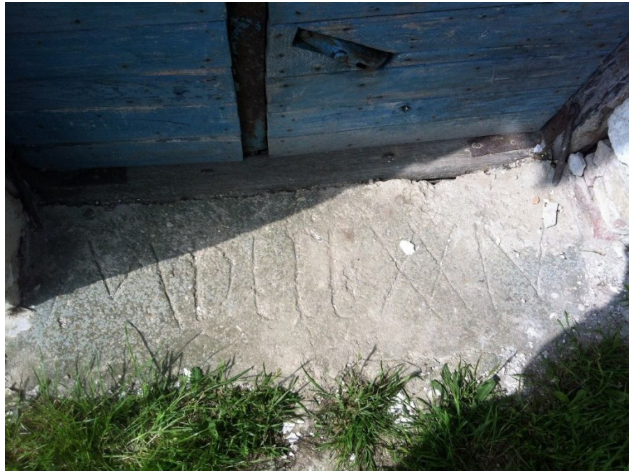
2.1.3. ábra A 0112/8 helyrajzi számú földrészleten található pince bejárata
