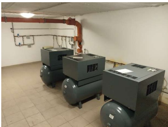
D.P.C. Szent László Telephely, 22-es épület, sűrített levegő központ
