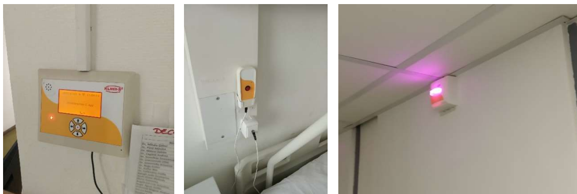
D.P.C. Szent László Telephely, 11-es épület, nővérhívó rendszer, központ, kórtermi jelző, folyosói jelző
