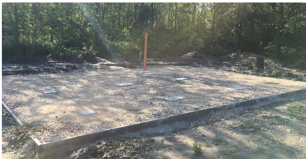
9. ábra: Beton pontalap
