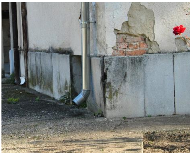
42. ábra Ereszcsatornák az épületek külső homlokzatán (forrás: saját fotó)
