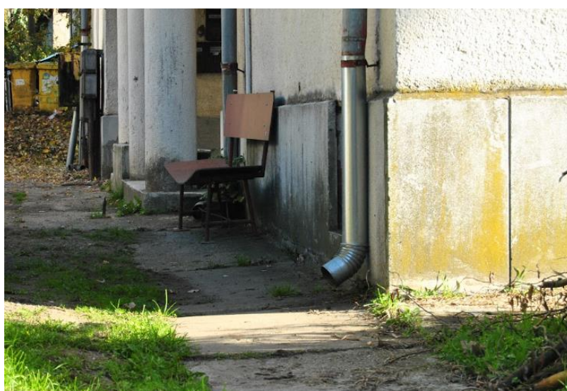
43. ábra Ereszcsatornák az épületek külső homlokzatán (forrás: saját fotó)
