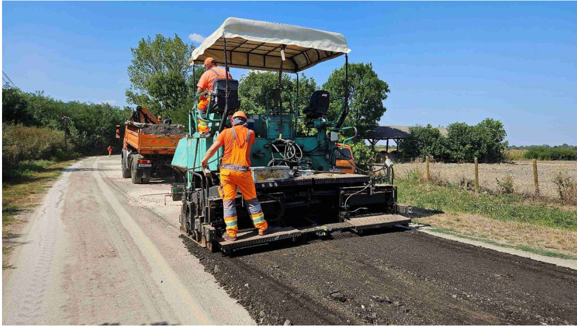
15. ábra Profilkiegyenlítést követően mart aszfalt alapréteg terítés a 42151. jelű úton Forrás: Saját fotó
