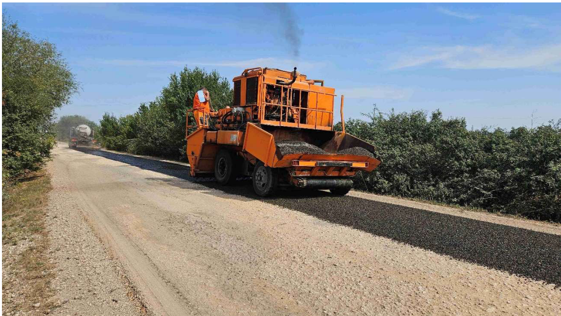
14. ábra Kétrétegű, szórt emulziós felületi bevonat készítése a 44105. jelű úton Forrás: Saját fotó
