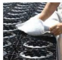
A geotextília teljesen körbe burkolja a szikkasztó rendszert
