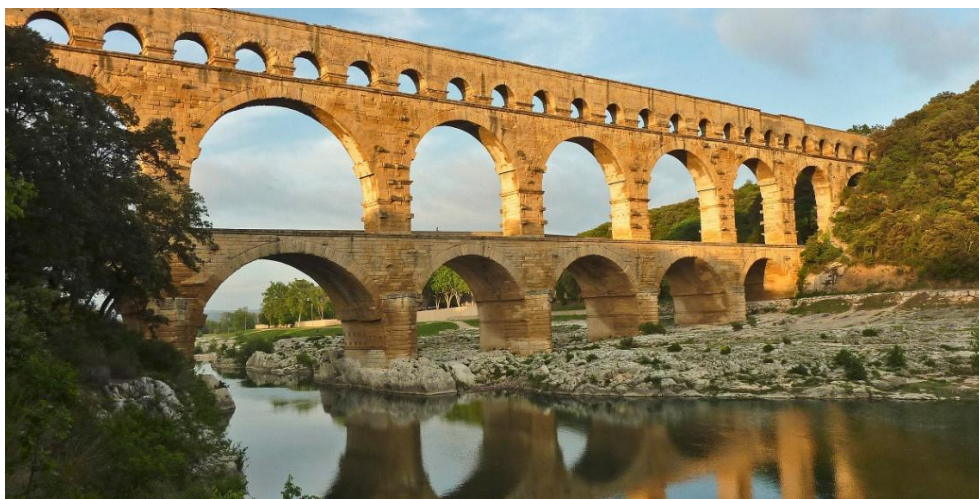
1. Kép Római csatorna viadukt [3]
