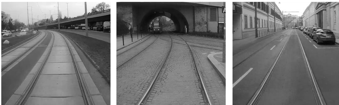
3. ábra. Balról jobbra: Betonlemezes, bazaltkőkockás és aszfalttal burkolt pályaszakasz
