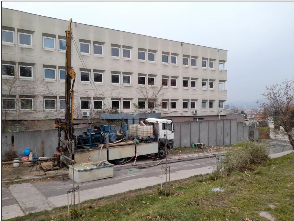
33. kép F1 jelű fúrás (Wirth-B1-A típusú fúróberendezéssel). Forrás:[13]
