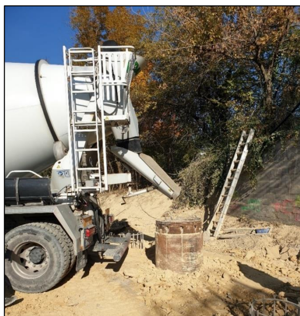
41. kép Betonozási előkészületek. Forrás: saját fénykép
