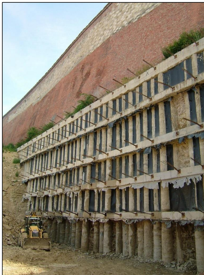
17. kép 5 sorban kihorgonyozott hézagos cölöpfal – Budapest, Budai Vár –Várgarázs. Forrás: [22]
