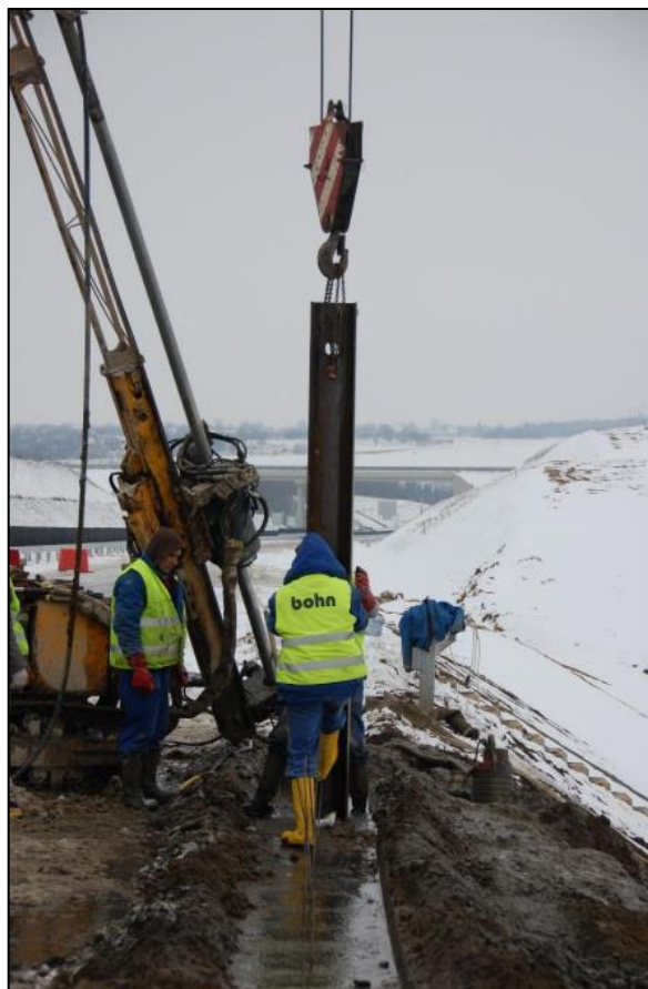
7. kép Acéltag beépítése jet-grouting falba. Forrás: [3]
