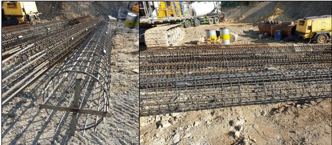
40. kép Cölöparmatúrák (bal oldalon az acél talplemez látható). Forrás: saját fénykép
