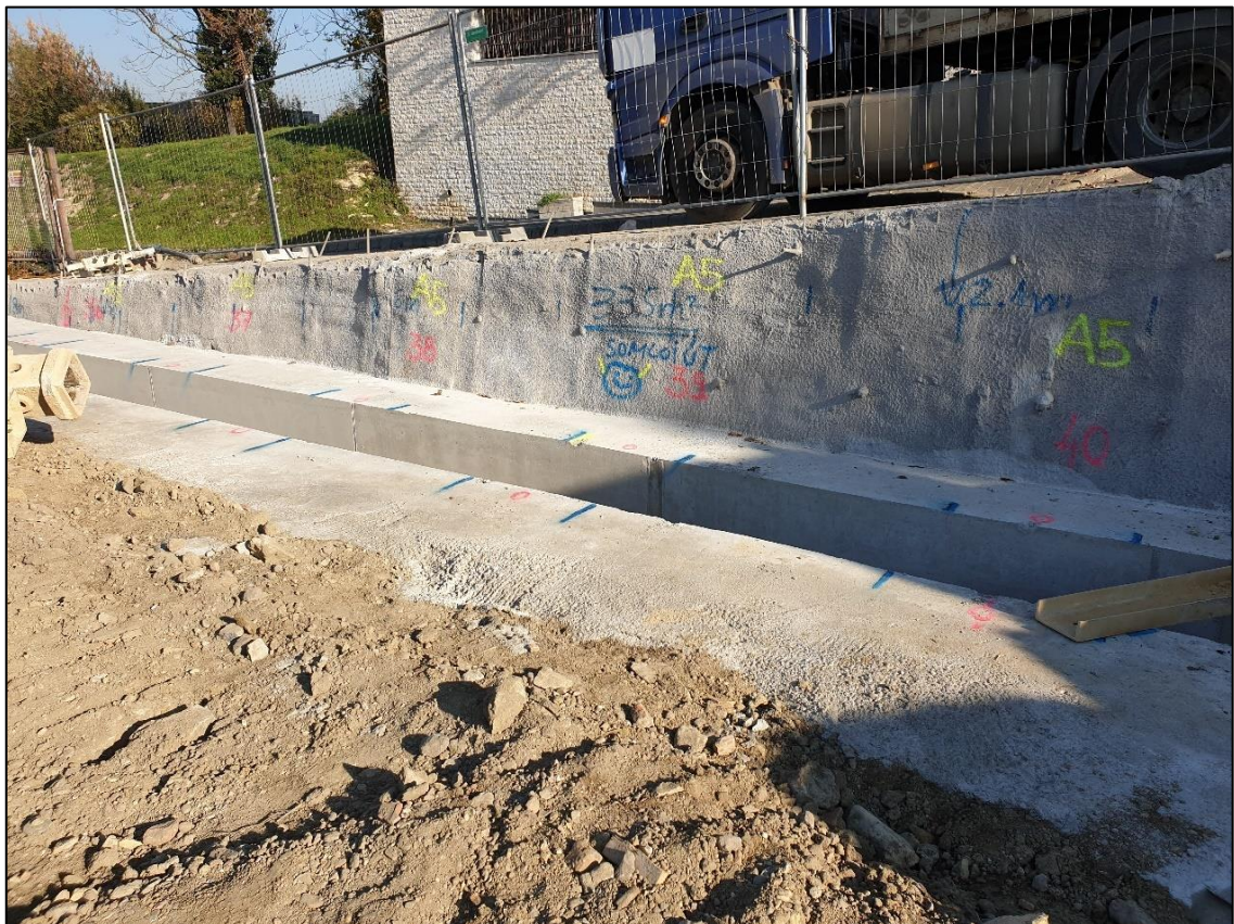
36. kép Lövellt betonnal fedett, szegezett talajtámfal és a cölöpvezető gerenda. Forrás: saját fénykép
