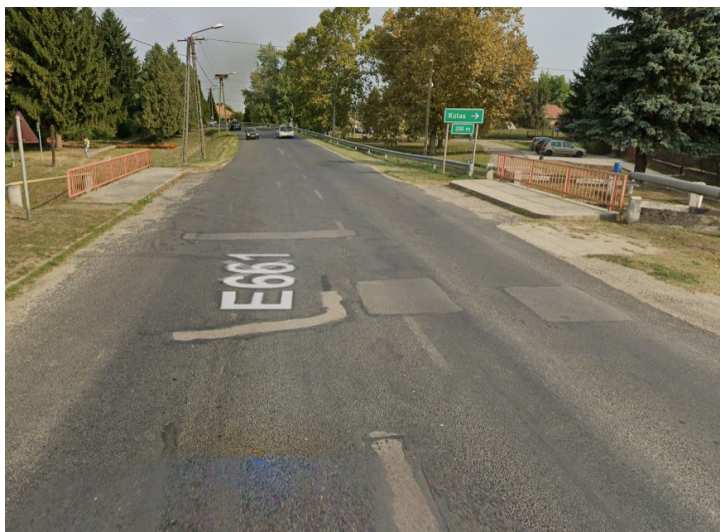
3-6. ábra Rinya-patak keresztezése és töltés kezdete (Forrás: https://www.google.com/maps/ A kép készült: 2021)
