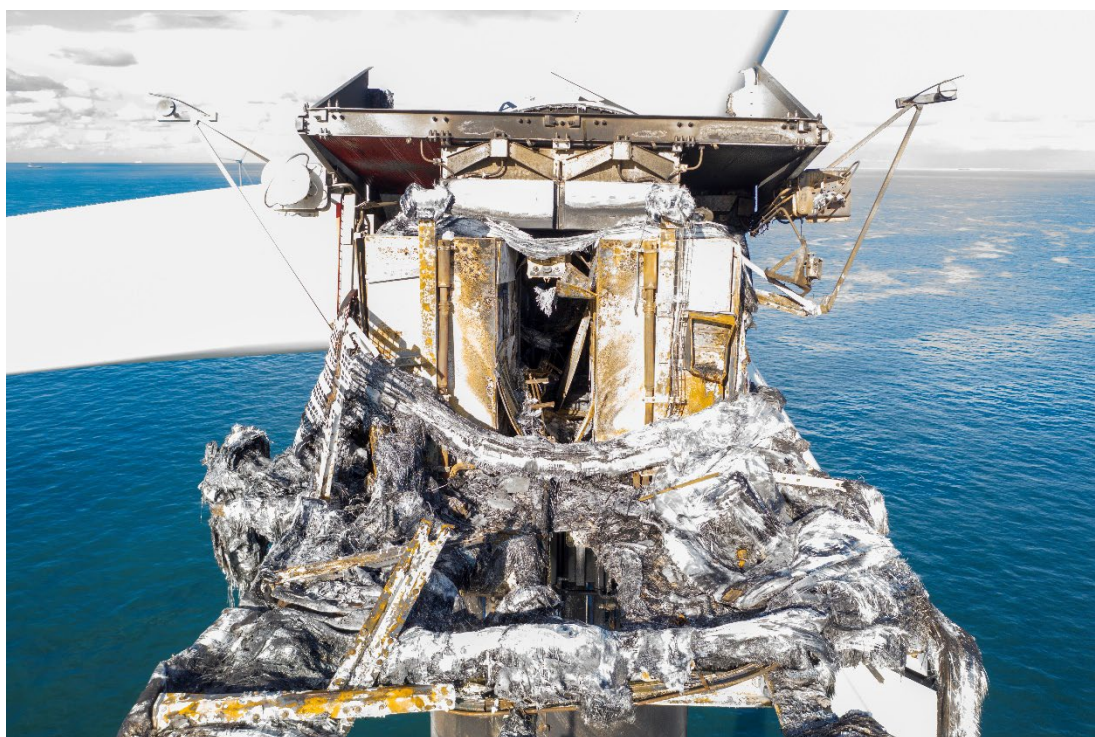
26. ábra: Utófeldolgozott fotó a műszaki hibás szélérőműről [Pál Károly]
