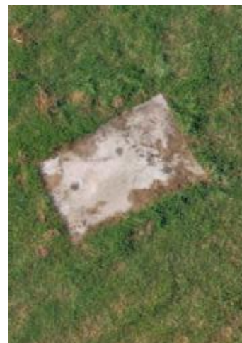
15. ábra: Terepen megtalálható betonfedlap illesztőpont
