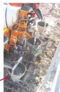
7. ábra A rés feltöltése betonnal
