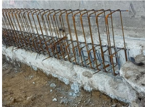
8. ábra A fejgerenda vasszerelése a résfalon
