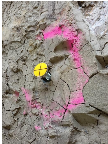
15. ábra Vizsgálati pont a résfalon
