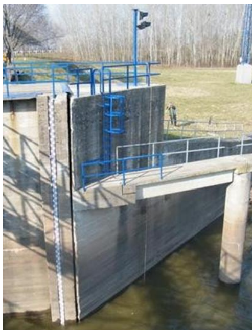
25. ábra Az alvízi betontest
