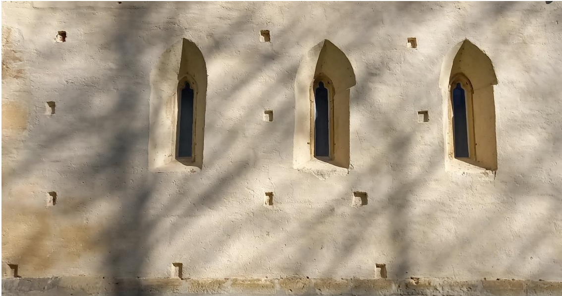
8. ábra A templom homlokzati nyílásai [saját kép]
