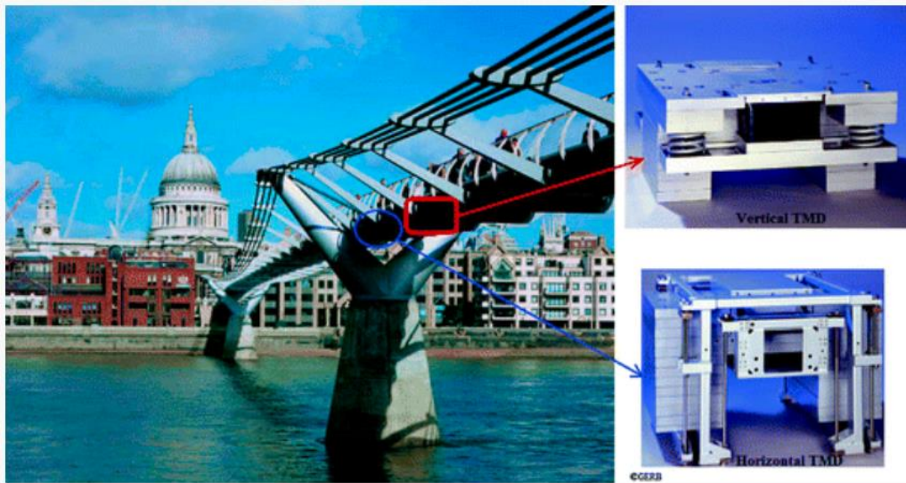
8. ábra A London Millennium Footbridge vertikális (jobbra fent) és horizontális (jobbra lent) irányú dinamikus rezgéscsökkentő egységei [13]
