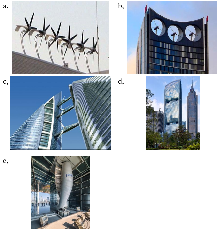
6. ábra. Épületre és épületekbe integrált szélturbinák. a, Szélturbinák egy lakóház tetején [27]; b, Strata SE1 torony szélturbinái [28]; c, Bahreini Világkereskedelmi Központ szélturbinái [29]; d, Gangzhoui Perl River torony [30]; e, Gangzhoui Perl River torony egyik szélturbinája [30]
