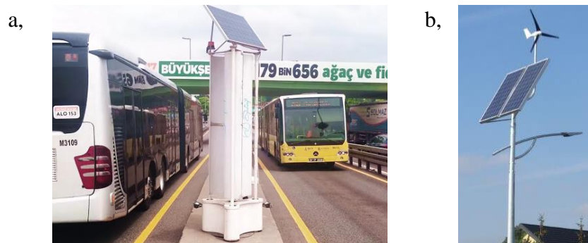
7. ábra. Városi környezetben található szélturbinák. a, Közlekedés menetszelét hasznosító függőleges tengelyű szélturbina [31]; b, Lámpaoszlopra szerelt napelem és szélturbina [32]
