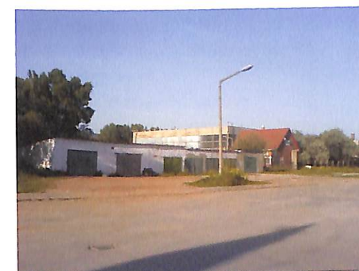
23. ábra 1-es számú melléképület
