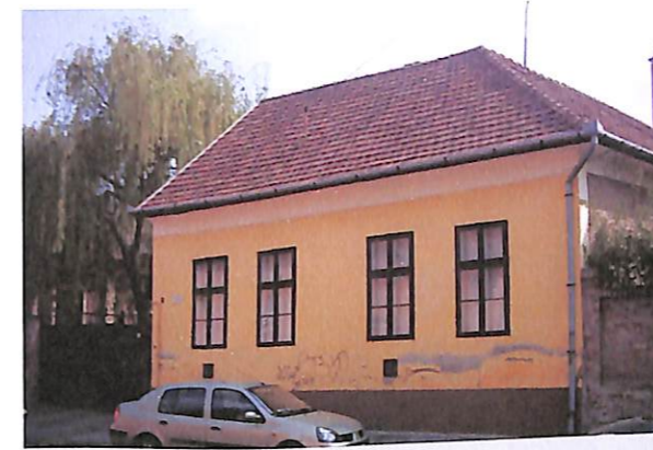
Eötvös tér épületegyüttese
