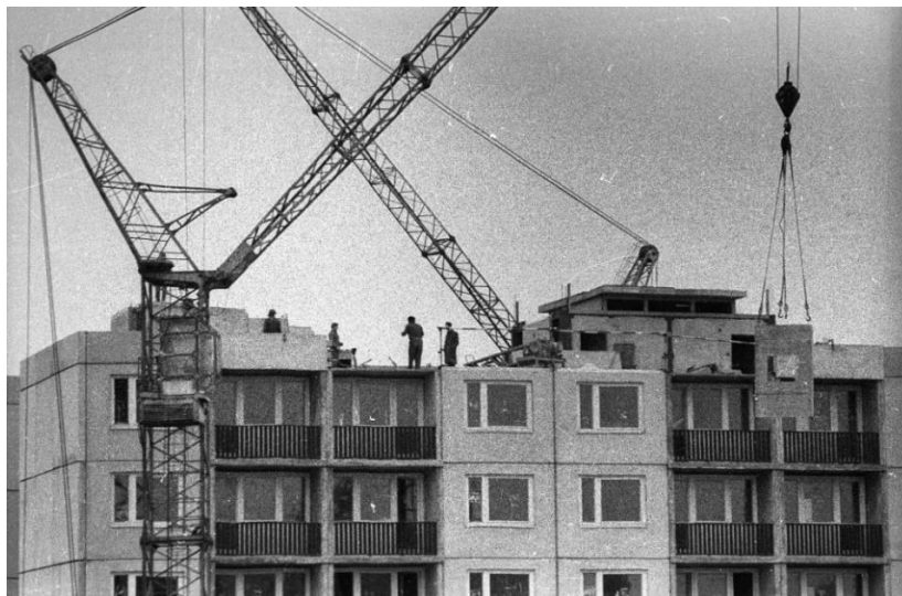
1.2. ábra: Előre gyártott panel elem beemelése
