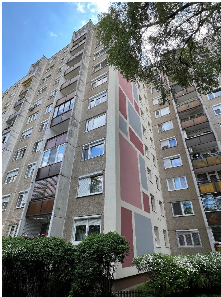
1.4. ábra: A félig felújított panelház
