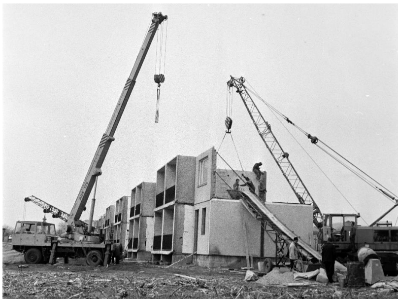
1.1. ábra: Panelház építése
