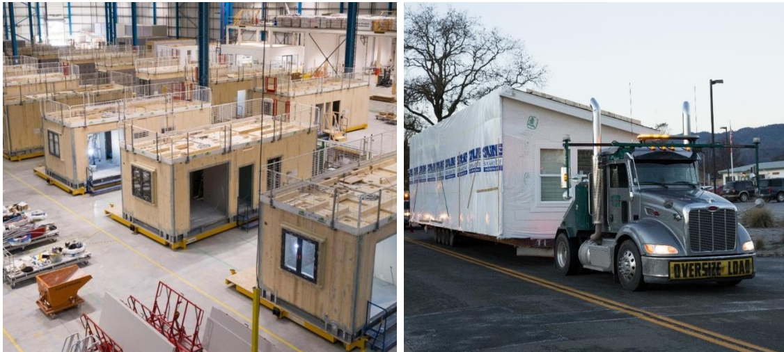
6. ábra: Nyílászárókkal felszerelt modulok gyártás, és szállítás közben
