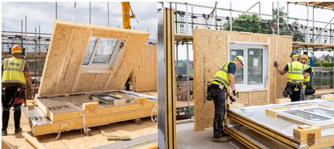
9. ábra: Könnyűszerkezetes paneles építkezés
