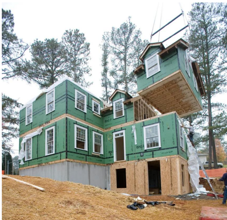
5. ábra: Moduláris otthon építés közben
