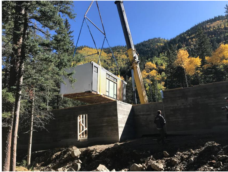
2. ábra: Moduláris otthon alapegység nyílászárókkal
