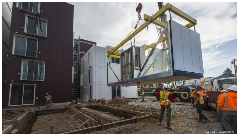
1. ábra: Moduláris otthon alapra helyezése
