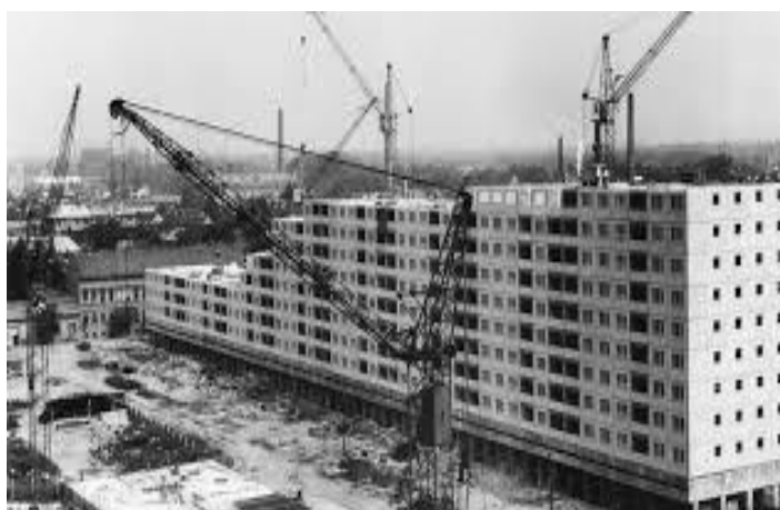
1. ábra Panelházak építése
