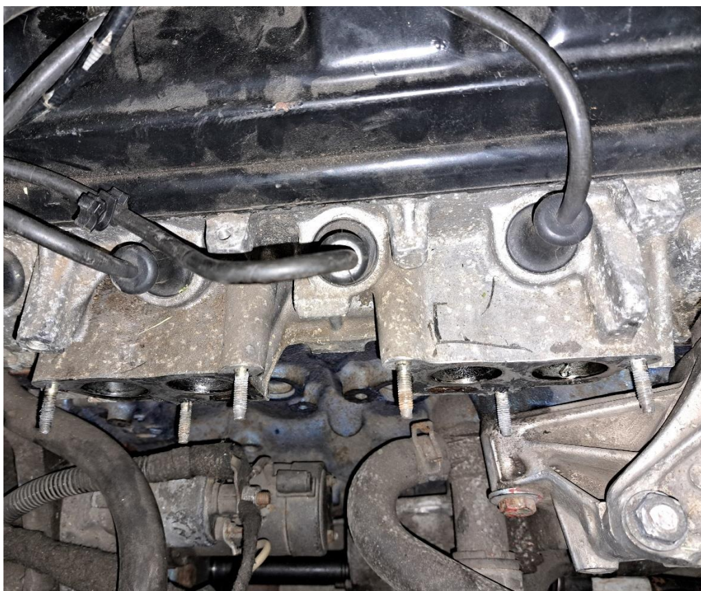
3.3. ábra, A szerelés helyszíne a tűzfalról nézve, még beépített szívócsonk nélkül (saját fotó)
