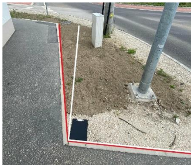
40. ábra Megépült járdaszakasz a helyszínen
