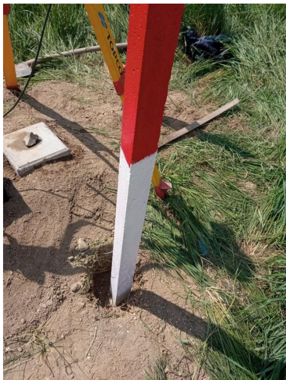
16. ábra Jelzőoszlopok létesítése és a pont jelölése (Saját kép)
