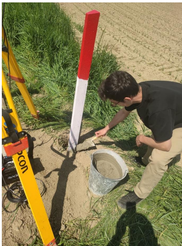
17. ábra Jelzőoszlopok állandósítása (Saját kép)
