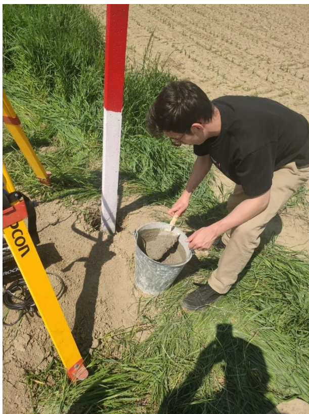
17. ábra Jelzőoszlopok állandósítása (Saját kép)
