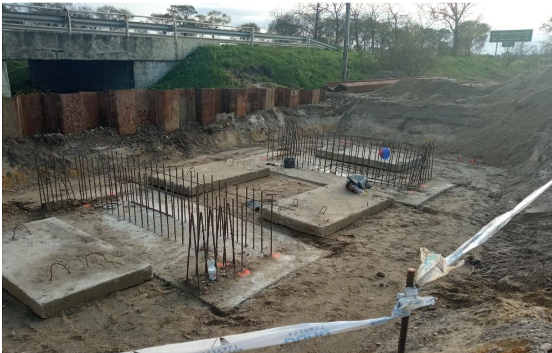
6.10. ábra: Alaptestek kitűzése [Forrás: saját kép]
