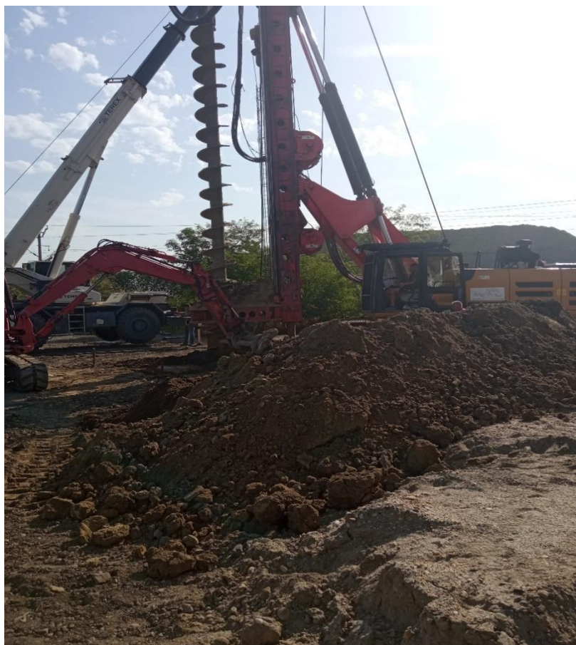
6.7. ábra: próbacölöp helyének fúrása, és elhelyezése [Forrás: saját kép]
