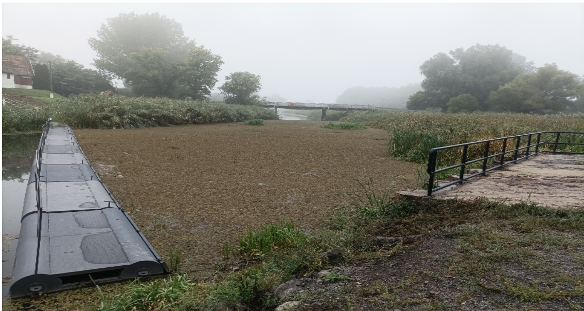
4. ábra: A Nagybaracscai uszadékfogó és a vízben úszó akadály [Saját fotó].
