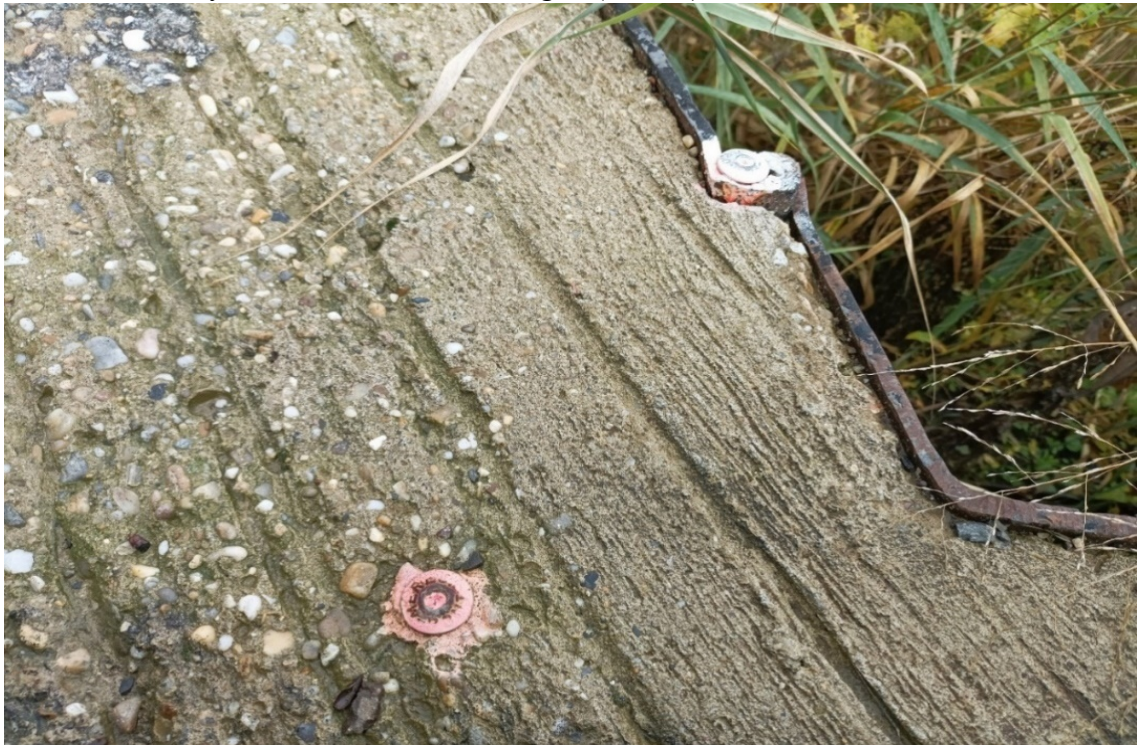
5. ábra: A betonban és a szádfalban elhelyezett Hilti szegek [Saját fotó].
