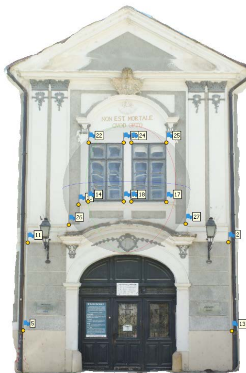
7.7. ábra: Dubniczay-Palota homlokzat modellje markerekkel [saját készítés - Agisoft Mteaphase Program]
