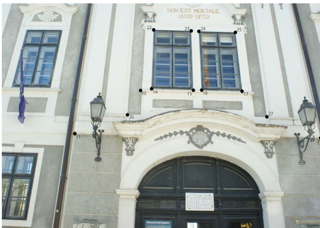
6.3. ábra: A Dubniczay-Palota pontvázlata 1. [saját készítés]
