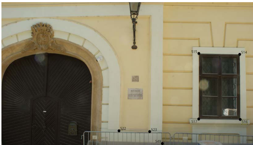
6.8. ábra: A VEAB székház pontvázlata 4 [saját készítés]
