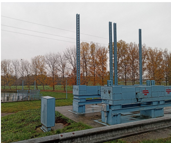
18. ábra. Zsilip a mentett, tó felőli oldalon (saját fotó)
