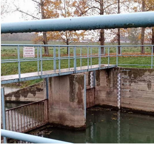
20. ábra. A zsilip mentett oldalán található vízmércék (saját fotó)
