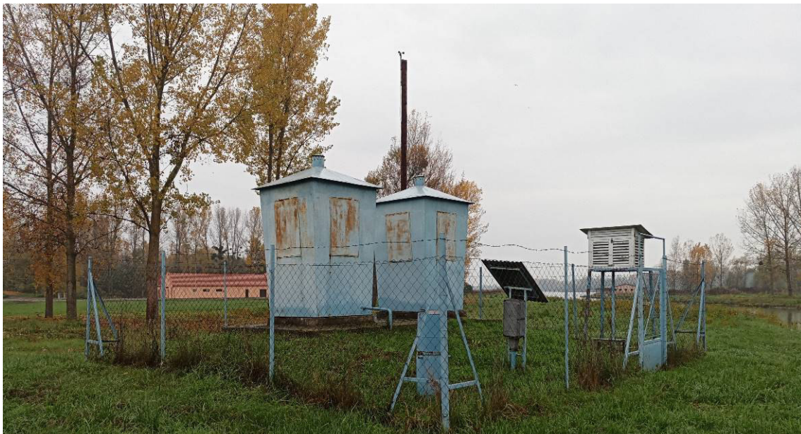
23. ábra. Hidrometeorológiai állomás, bal oldalon háttérben a csónakházzal (saját fotó)
