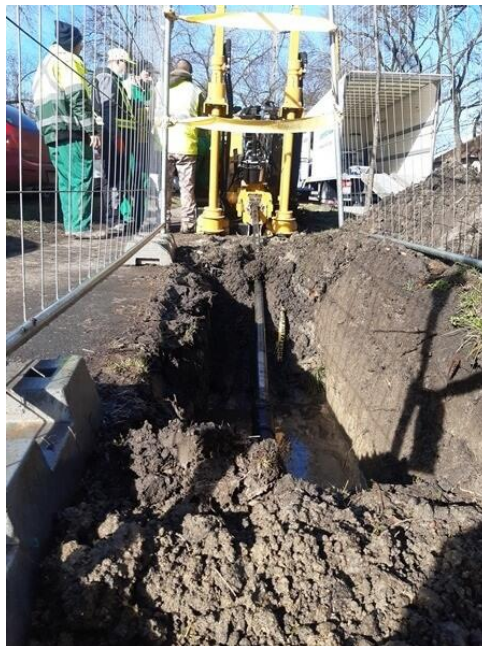
9. ábra: az irányított fúrás a helyszínen
