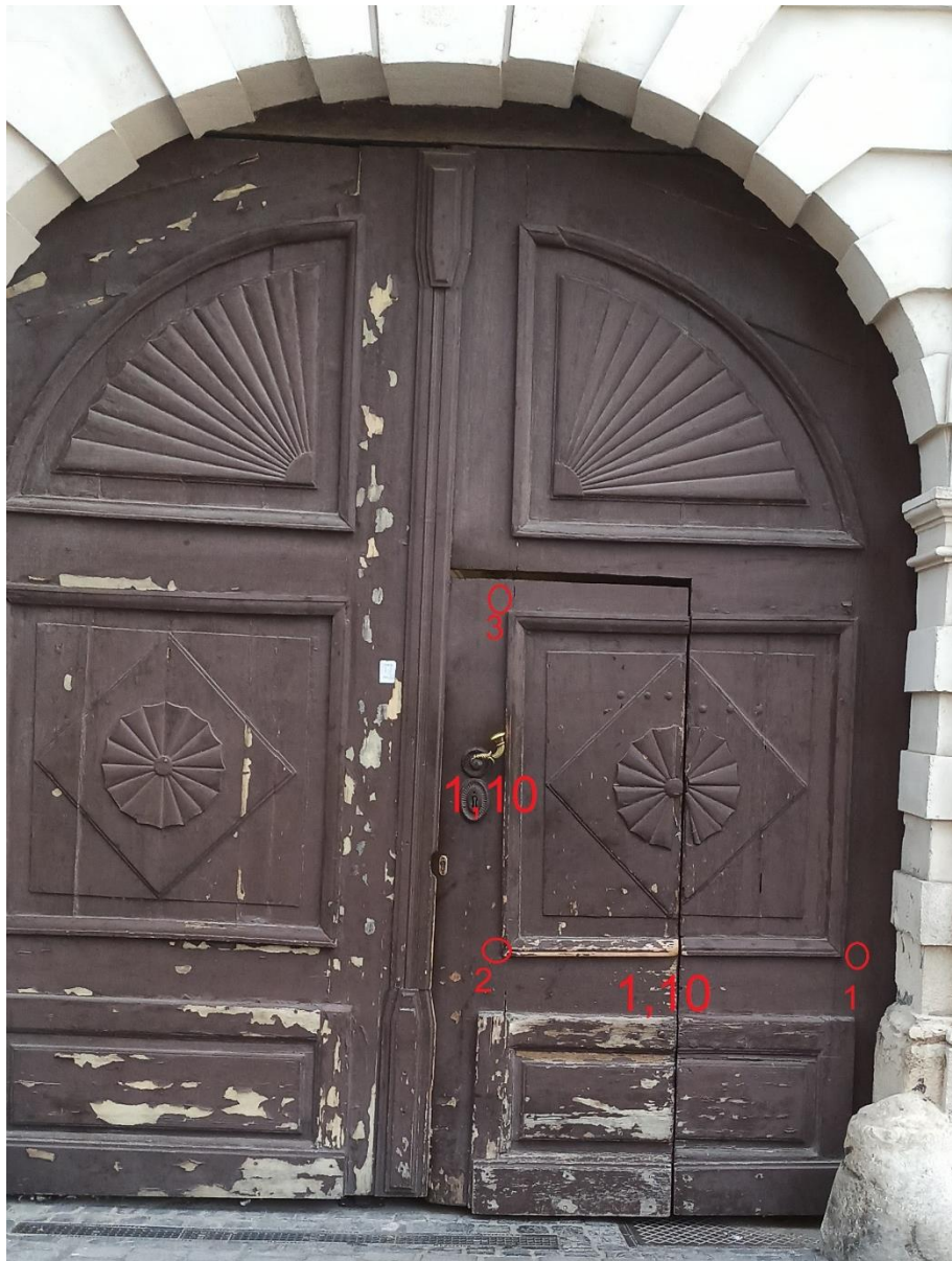
42. ábra: Az illesztőpontok elhelyezkedése, egymástól való távolsága
