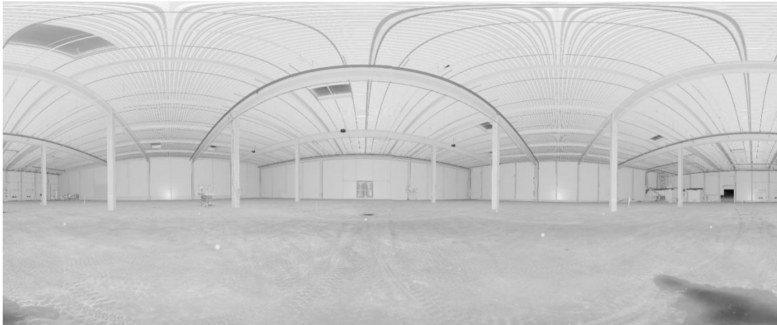
12. ábra: Faro Focus S150 által készített panorámakép.
