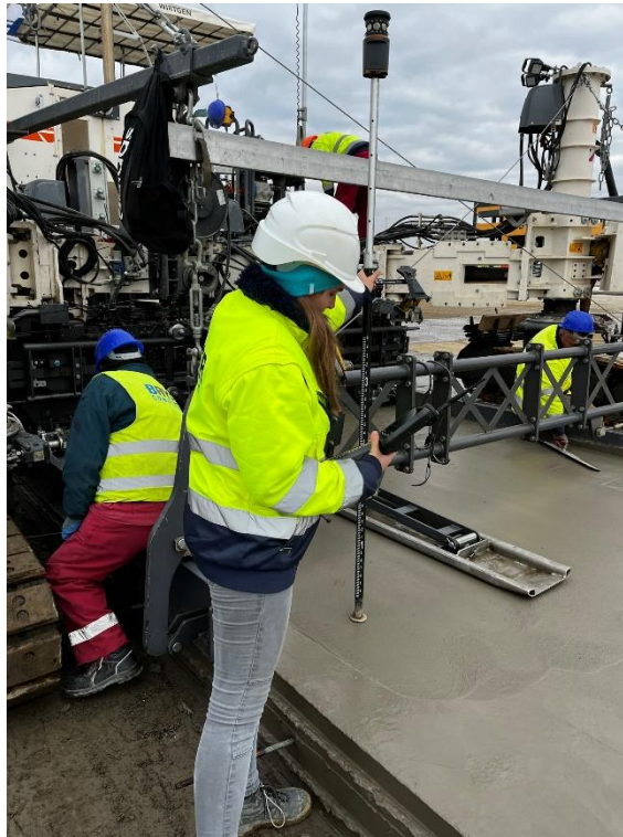
7.10. ábra Beton magasságának ellenőrzése (Forrás: Saját kép)
