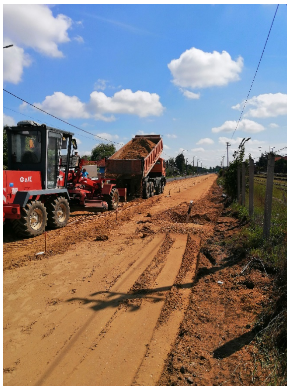
4. kép - Védőréteg terítése (Forrás: Saját)
