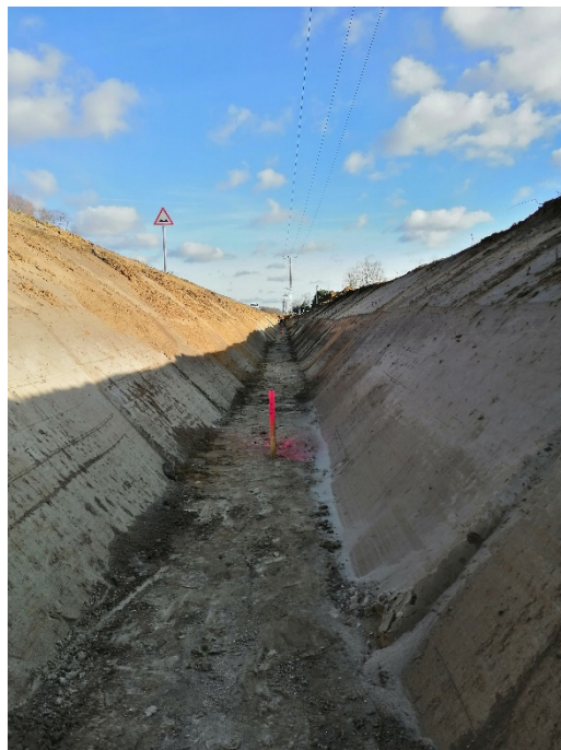
5. kép - Árok tűzése (Forrás: Saját)
