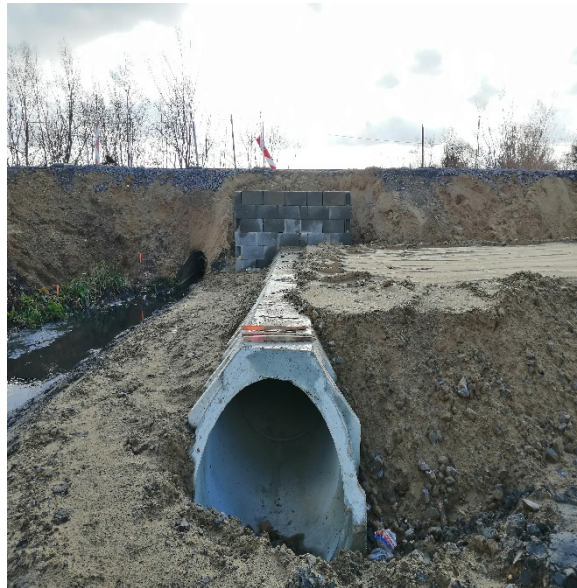
10. kép - Megépített áterszt (Forrás: Saját)
