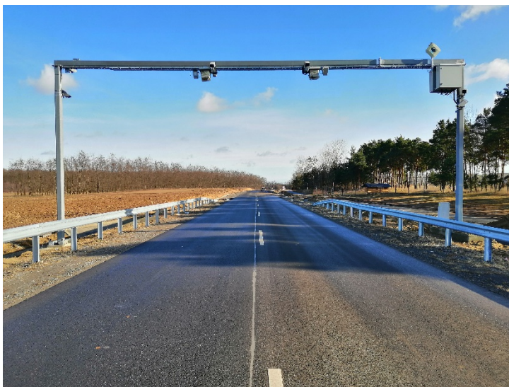
6. kép - VÉDA portálszerkezet (Forrás: Saját)
