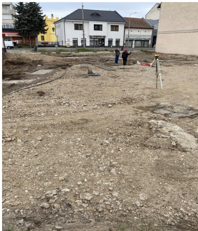
8. kép: Kontroll szintezés (saját kép)
