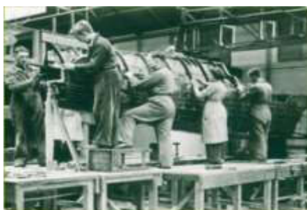
1. ábra: Első kompozit repülőgéptörzs gyártása (Spifire Hexcel, Nagybritania, 1940)
