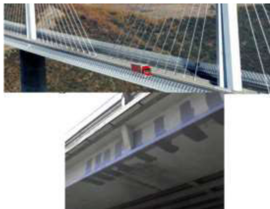
23. ábra: Kábelek műtárgyak megerősítésére
