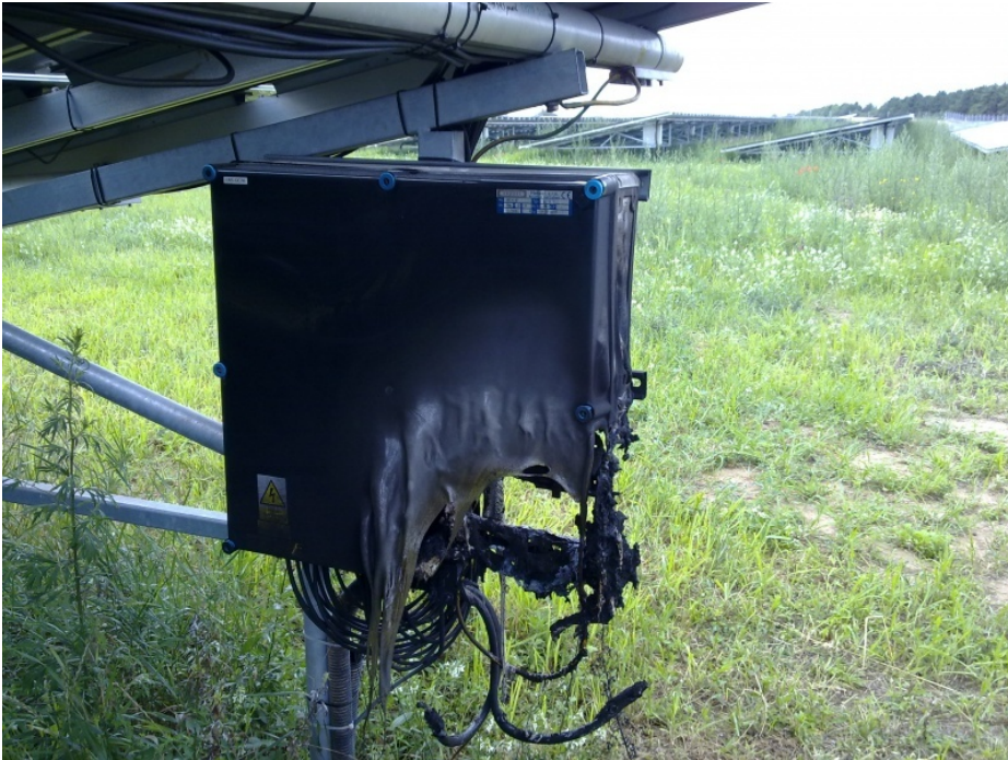
5. ábra: Fotovoltaikus rendszer kapcsolódobozza tüzesetén után (Forrás: https://www.villanylap.hu/images/1751-1488969483.jpg )
