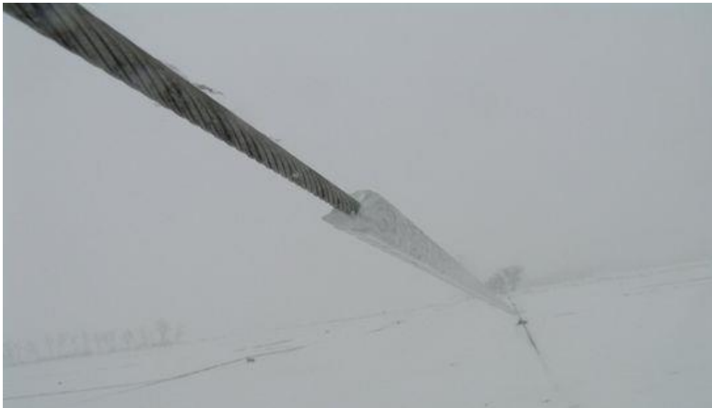
18. ábra. A sodronyokra rakódott rendkívül vastag jégréteg. [13]
