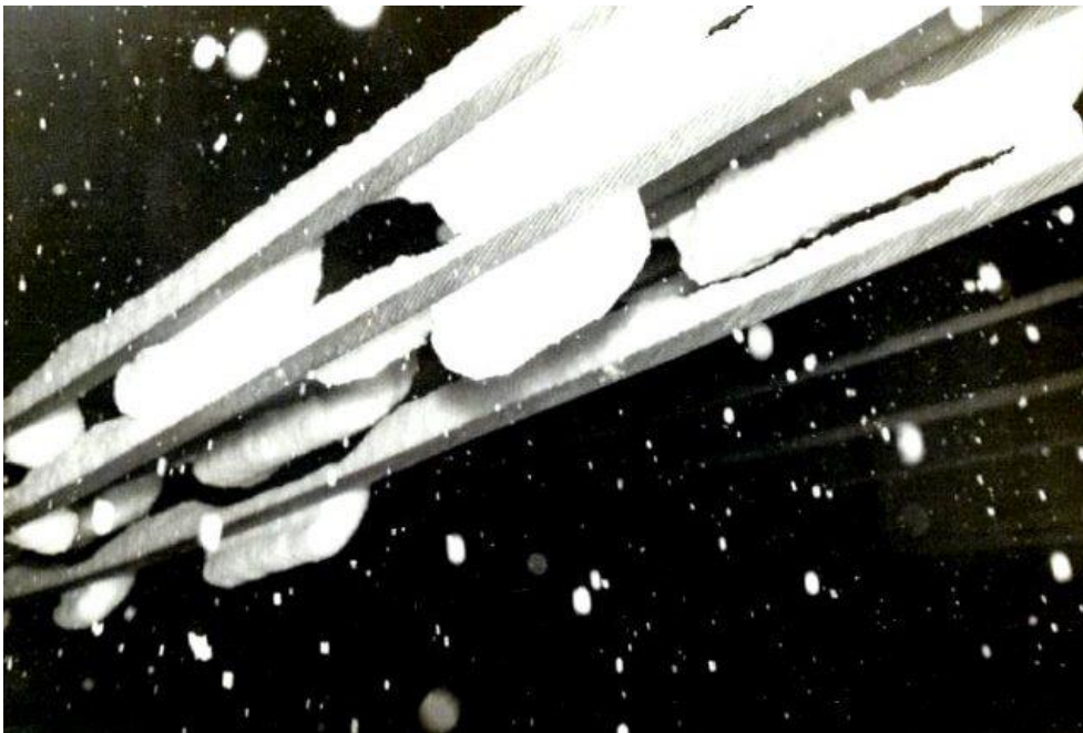
16. ábra. Száraz hó szabadvezetési sodronyon [10]
