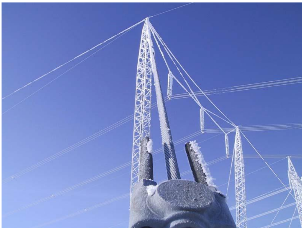
17. ábra. Dér felhalmozódás kikötött portálon [10]
