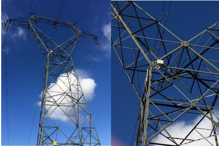
44. ábra. Mérőberendezés elhelyezése a távvezetéki oszlopon
