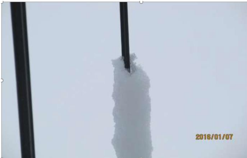
19. ábra. A sodronyokra tapadó jég és hó. [14]
