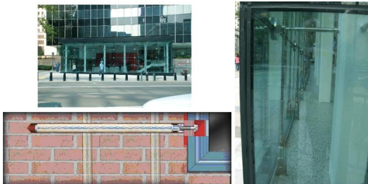
29. Képek: Ablakkeret horgonnyal történő falhoz rögzítése, ablak mögé kiépített rácshálózat [17, p. 86]
