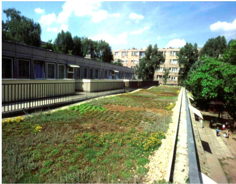
Kísérleti célú extenzív zöldtető egy budapesti óvoda épületen
