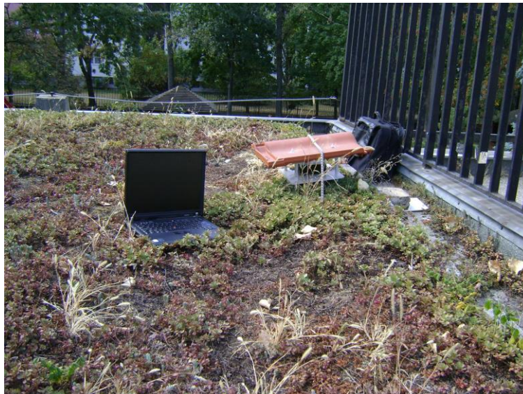
4.5. ábra a zöldtető és a betontető a mérőberendezéssel
