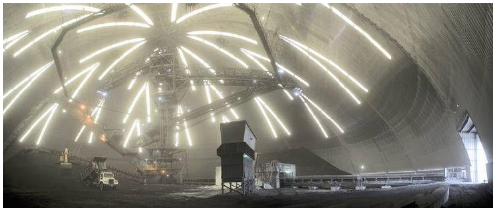
7. ábra - Széntároló csarnok (Florida) 84
