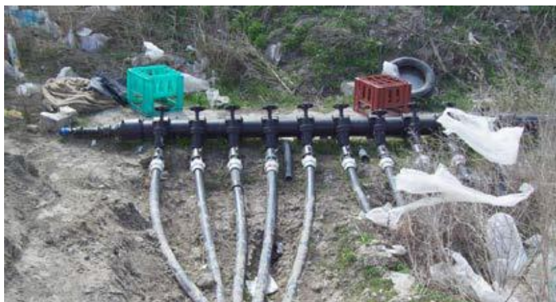
5. ábra Gázutak gyűjtőcsomója egy működő depóniagáz telepen (Forrás: Saját kép)
