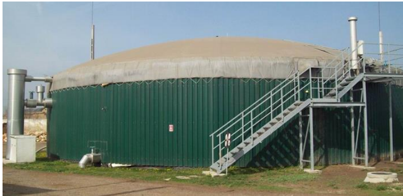
7. ábra Mezőgazdasági alapanyaggal üzemelő, lapos elrendezésű biogáz üzem Kecskemét – Pilze-Nagy Kft. (Forrás: Saját kép)
