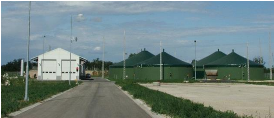
21. ábra A dömsödi biogáz telep (Forrás: ELMIB – tiszta energia, 2010.)
